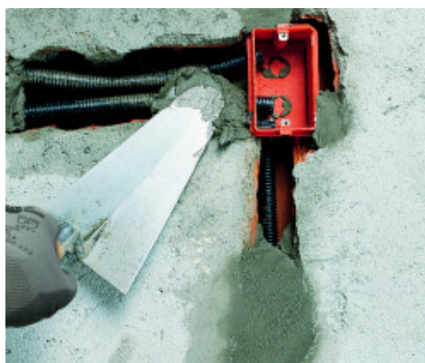
Montage van elektrische installaties met Lampocem Blitzement
