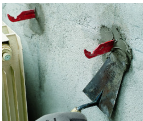
Bevestigen van verwarmingsbeugels met Lampocem Blitzement
